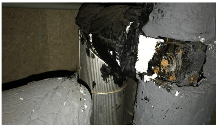
Figura 5 – Válvula 3 Vias Desativada
