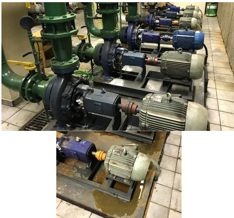
Figura 3 – Bombas de Água Condensada e Bombas de Água Gelada (vazamento de água excessivo)
