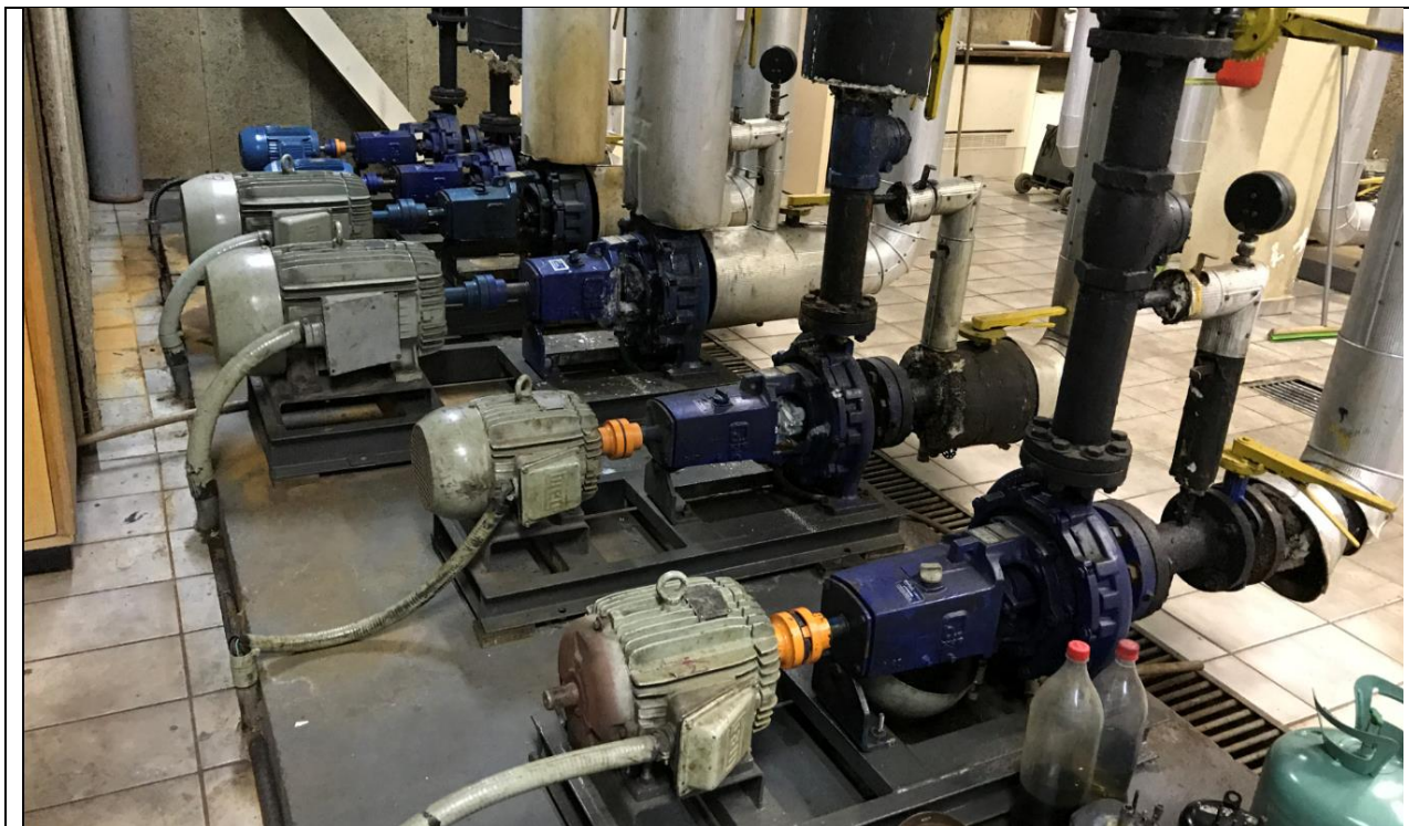
Figura 4 – Bombas de Água Circuitos Secundários
